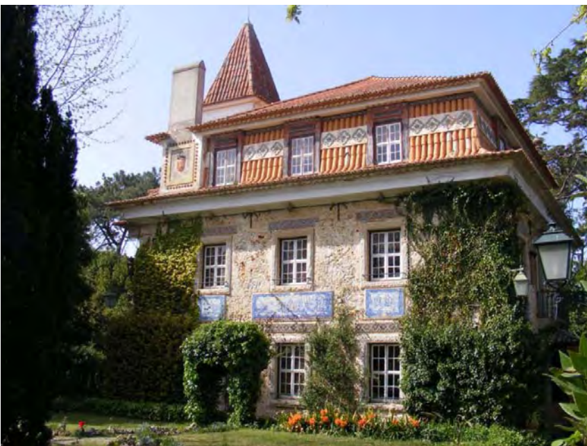
2 - Palacete Visconde de Sacavém. Fachada Sul. Caldas da Rainha
