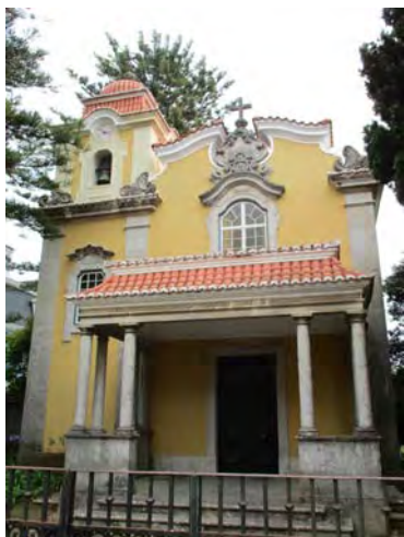
19 – Fachada principal da Capela de Nossa Senhora da Piedade (Fotografia do autor).
