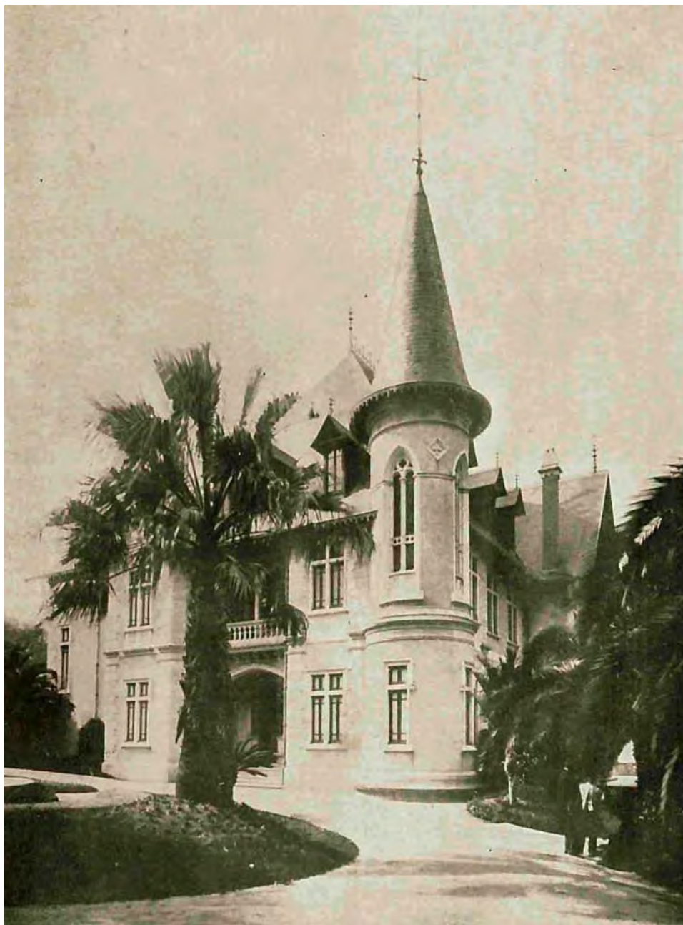
9 – Fachada principal e lateral, com o volume no cunhal do gabinete e da capela (Fonseca, 1908: Intercalar VII).
