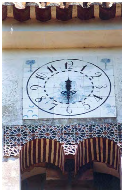
5 - Palacete. Fachada Sul e pormenor da Torre com o Relógio. Caldas da Rainha.
