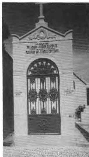
Fig. 5 — Cemitério do Alto de S. João. Capela estereotipada do início do séc. XX.
