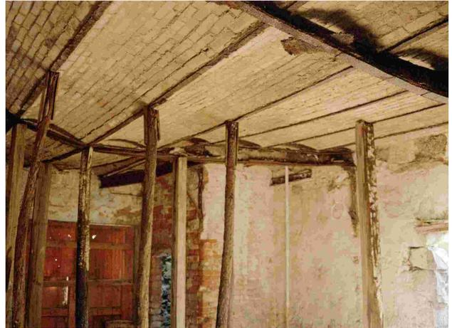
Fig. 40. Este trecho de um dos edifícios do quarteirão sul já não existe, dado que o escoramento foi insuficiente para compensar a fragilidade das vigas, profundamente atacadas pela oxidação derivada de uma exposição contínua às intempéries. Apesar de tudo, as coberturas podem ser reconstruídas nas partes em falta, dado que estão registadas em imagens.
