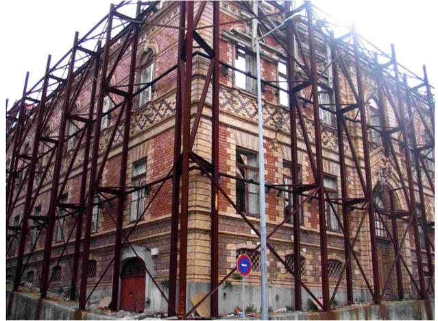
Fig. 27. Este edifício, concluído em 1894, também integrava o complexo fabril. As suas fachadas são únicas no país e constituem o exemplo máximo da cerâmica aplicada à arquitectura do fim do século XIX. Depois de estar subdividido e arrendado pela Misericórdia de Gaia, que herdou o legado de António Almeida da Costa, ficou devoluto e acabou por ruir no seu interior. Há anos que se encontra escorado.
