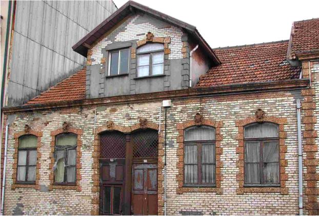
Fig. 24. Uma das casas do chamado "bairro dos contramestres", sendo evidente o abandono da mesma e a degradação dos revestimentos cerâmicos, assim como as tentativas ingénuas de restauro, cujos materiais empregues só têm acelerado mais a degradação.
