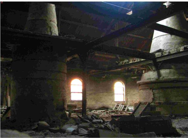
Fig. 44. Secção superior de dois dos fornos de faiança da Fábrica de Cerâmica das Devesas.
