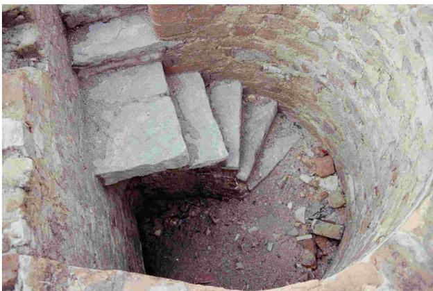
Fig. 41 e Fig. 42. Uma das várias cisternas do quartelão sul e uma escadaria para um subterrâneo no mesmo quartelão, estruturas que não surgiam em plantas antigas, as quais geralmente registavam apenas estruturas ao nível do solo. Estas, que as imagens mostram, foram descobertas pelas sondagens arqueológicas preliminares, pelo que é de esperar ainda mais algumas surpresas neste quartelão sul, que muito poderão enriquecer o desejado projecto museológico integrado.
