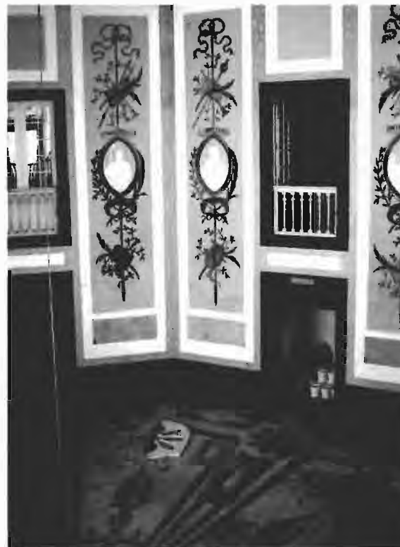
23. Capela mortuária do Prado do Repouso, restauro do pavimento
